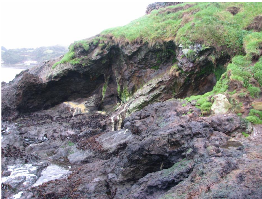
Fotografía N° 13: Unidad Geomorfológica de Borde Rocoso
