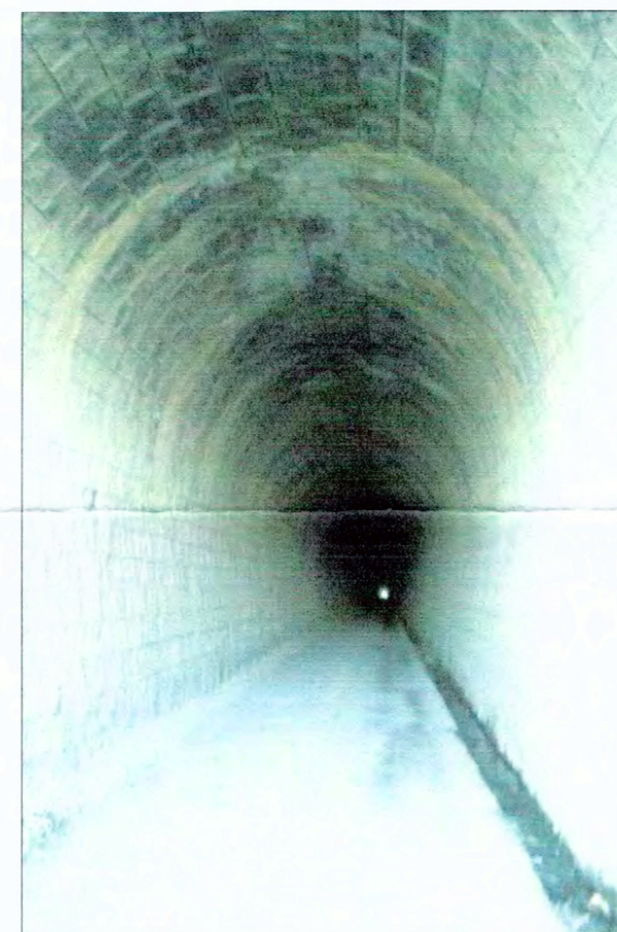
INTERIOR DEL TÚNEL
