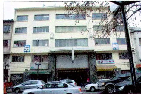
Vista fachada principal por calle San Diego
