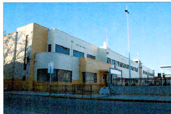
Vista esquina surponiente de Escuelas Concentradas de Talca. Fotografía año 2010.
