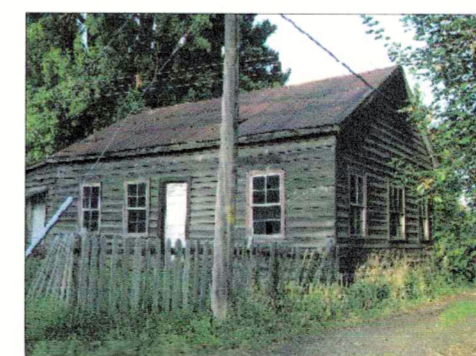
Vista fachada principal Casa de Trabajadores
