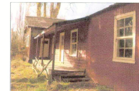
Vista acceso principal Casa de Administrador
