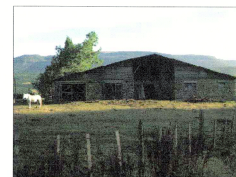
Vista acceso Cocina de Peones
