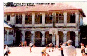
VISTA SURORIENTE (patio)
