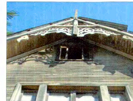
Vista de detalle de la fachada principal
