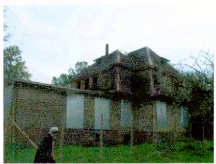
Vista parcial suroriente
