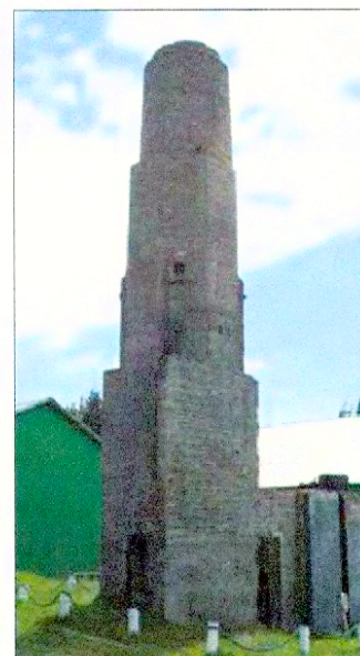
Vista sur de la Chimenea
