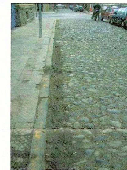
Detalle de la calzada y vereda calle Ricaurte, vista hacia el oriente
