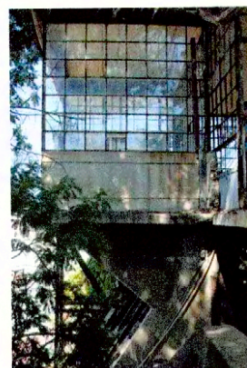
Vista estación superior
