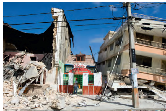
Daños en el distrito comercial, Puerto Príncipe.
