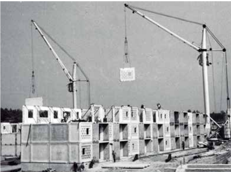
Montaje de paneles KPD
