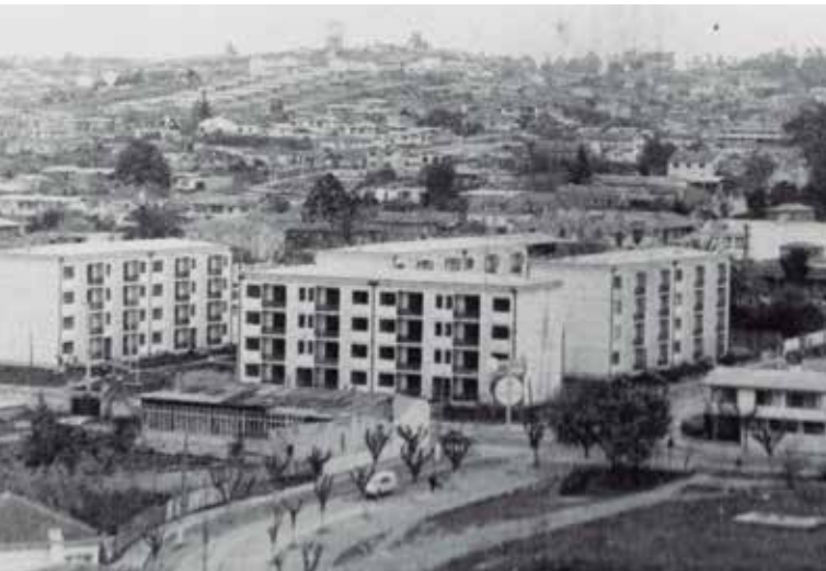
Vista panorámica de faena de construcción de edificios KPD en Quilpué.
