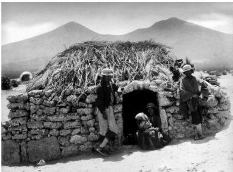
Su construcción consiste en un techo compuesto por estratos de paja, llamada en aymara **ichu (stipa ichu)**, especie de paja bastante larga y dura que crece en grandes cantidades sobre las faldas de los montes. Estas se colocan en distintas formas de disposición que se van entrelazando para armar una especie de cama con una rejilla de cuero de llamo. Todos los nudos de la casa también son en base a este material, que se corta solo desde el cuello del animal, que es el más
