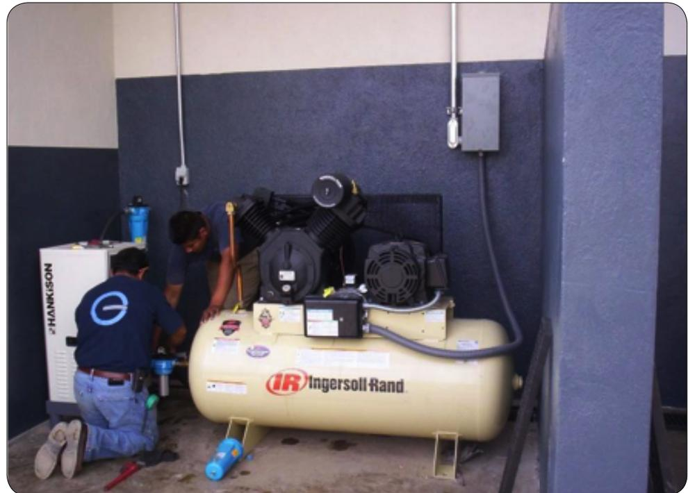
**Figura 5.** Instalación de compresor industrial
