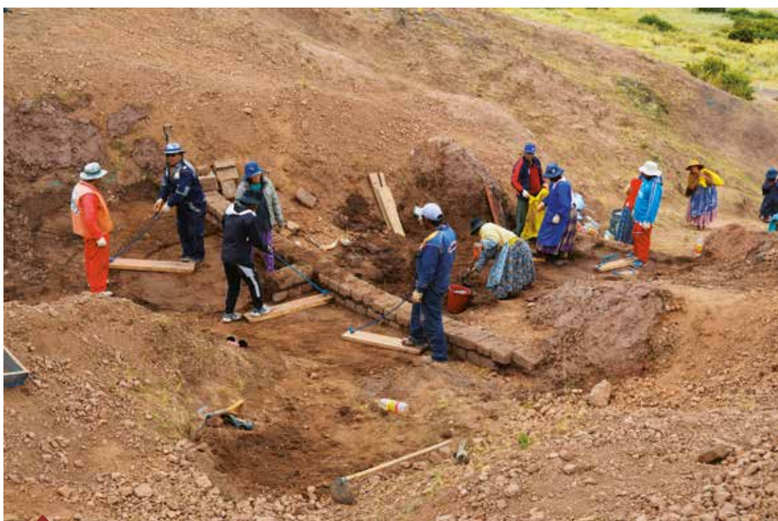
Ilustración 83. Proceso de restauración del núcleo de la pirámide de Akapana, mediante la reposición de material a través de la fórmula original de construcción. 2017. Obsérvese la composición de la estructura, basada en la adición consecutiva de capas de arcilla apisonada.
