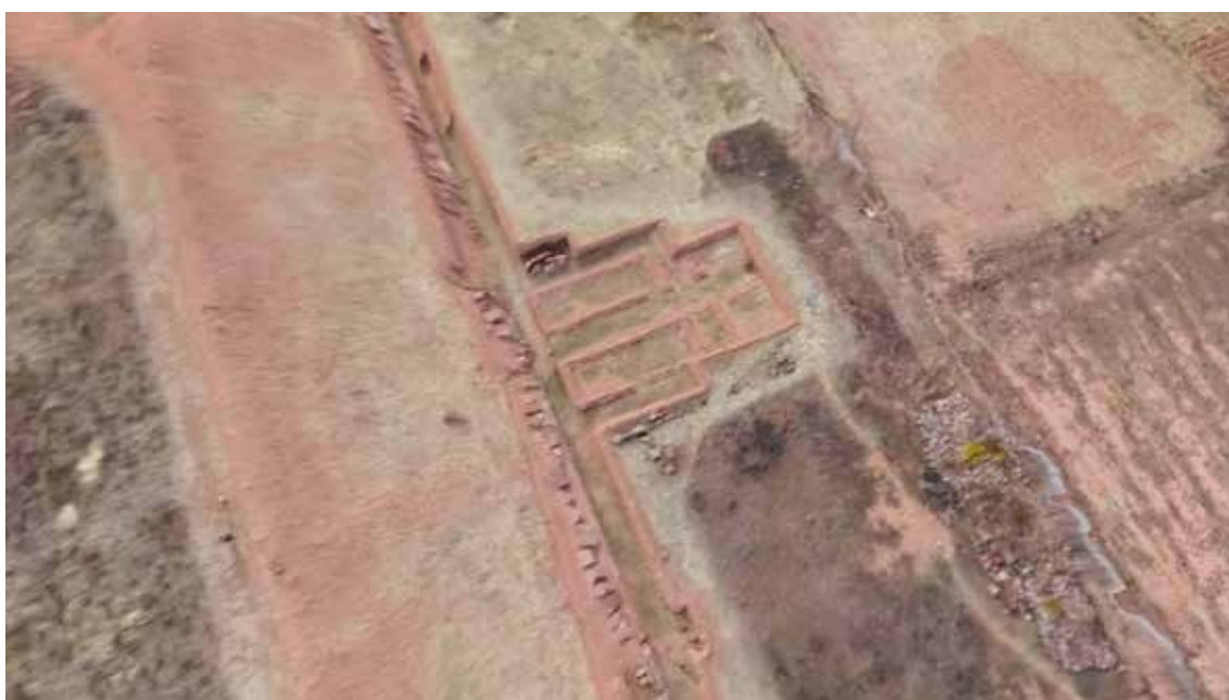
Ilustración 65. Elementos constructivos de época incaica al norte del edificio principal de Puma Punku. Ortoimagen RGB sobre modelo digital del terreno generado por el dron.
