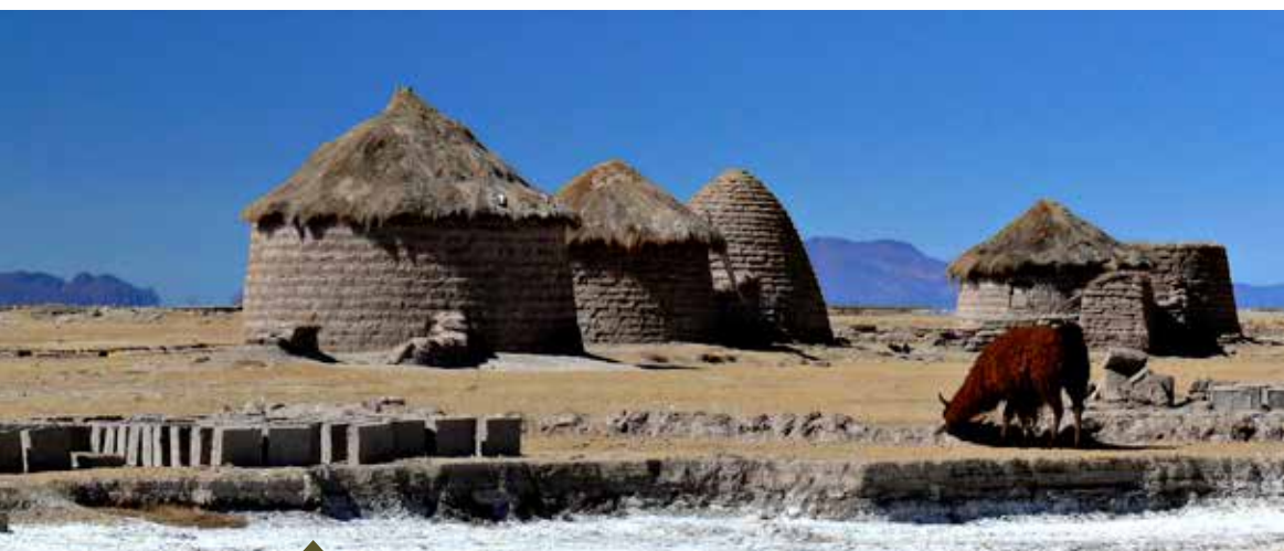
Ilustración 46. Viviendas circulares tradicionales del altiplano boliviano, construidas de barro y techo vegetal. Altiplano boliviano 25 . Imagen cortesía de Matteo Porta
