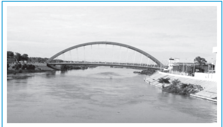
Puente sobre el Río Piura, Perú.
