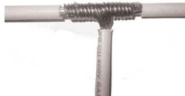
Figura 30. Fotografía cable T
