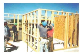
Figura 10 - 73c: El elemento finalmente es levantado, anclado y fijado sobre su eje de ubicación de forma rápida y expedita.
