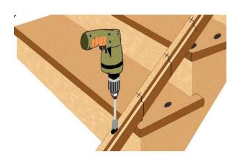
Figura 12 – 37: Perforaciones para la colocación y fijación de balaustres.
