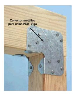
Figura 9 – 45: Conector metálico que une vigueta de plataforma de terraza con pilar.
