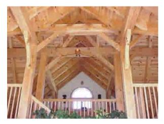
Figura 6 - 7: Conjunto de elementos estructurales, vigas y pilares a la vista en el interior.
